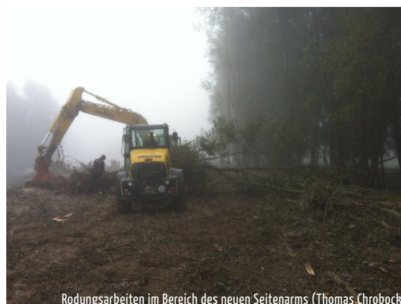
Rodungsarbeiten im Bereich des neuen Seitenarms (Thomas Chrobock)
