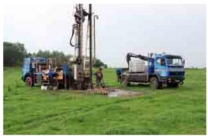
Leichte Rammkernsondierungen (links) und Tiefenbohrungen mit schwerem Bohrgerät (rechts) für die Untersuchung der Bodenverhältnisse. Insgesamt wurden 10 Rammkernsondierungen und 8 Tiefenbohrungen durchgeführt.
